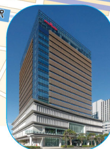
★ 株式会社村田製作所 みなとみらい イノベーションセンター (47) Murata Manufacturing Minatomirai Innovation Center
