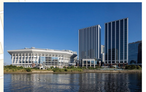
K タワー横浜 (60・61 街区) [2023 年 7 月竣工] K tower yokohama (Blocks 60 and 61) [Completion July 2023]
