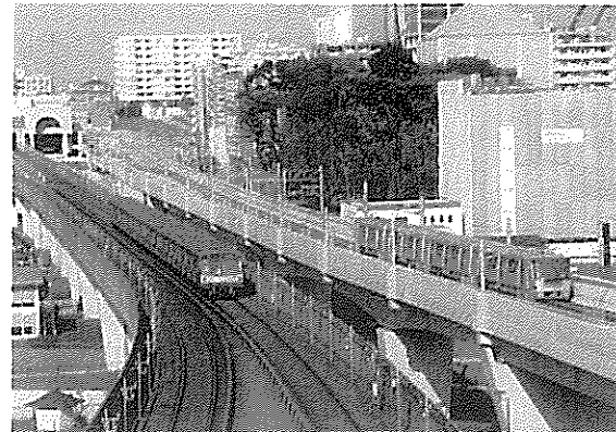
センター南～センター北間 走行試験
