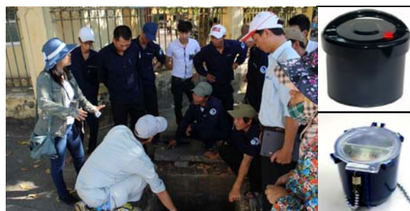
② 水道テクニカルサービス株式会社 フエ省で漏水を発見した漏水探査装置の設置 (右上：配水管用 L-Sign、右下：給水管用 L-Sign)
