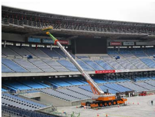
(横浜国際総合競技場の工事の状況)
