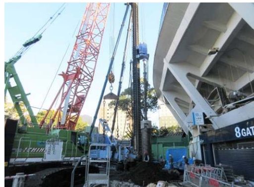
(横浜スタジアムの工事の状況)
